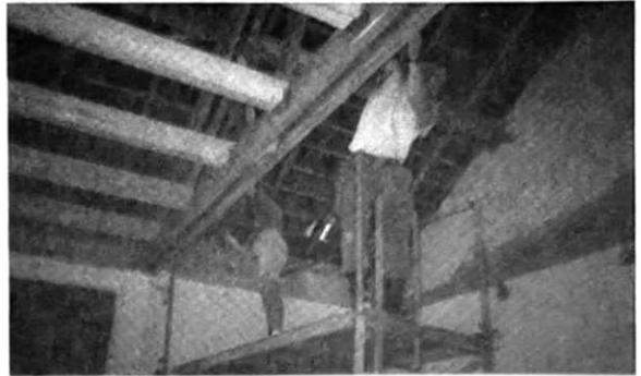
Im Juni wurde der Boden im Dachgeschoß isoliert und der Plattenboden verlegt.
